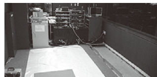
④撤去後の調整室
