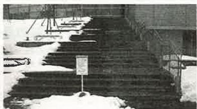
ホール南側の黒沢川付近からホールへ向かう階段 (写真右側の床下に融雪設備が埋設されているため雪が溶けている)
